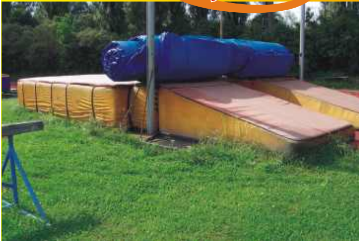
Stav před rekonstrukcí
